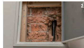
1.2階の「歴史と文化のフロア」には、北海道の遺産をはじめ、道内各地の文化や歴史を紹介する展示室が設けられている 2.れんが壁に縦穴を開け、銅棒を挿入して基礎に固定している様子が展示されている
