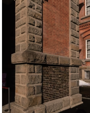
建物下部の色の濃い部分は「焼き過ぎれんが」。高温で焼成され、密度が高く吸水を抑える特性があるため、基礎まわりや湿気の多い部分を守るために用いられた
