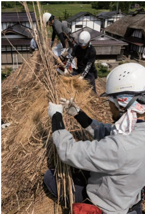
約20年周期で行われる茅葺き屋根の葺き替え。風雨にさらされ傷みやすい屋根の頂部「グシ（棟）」をつくる様子
