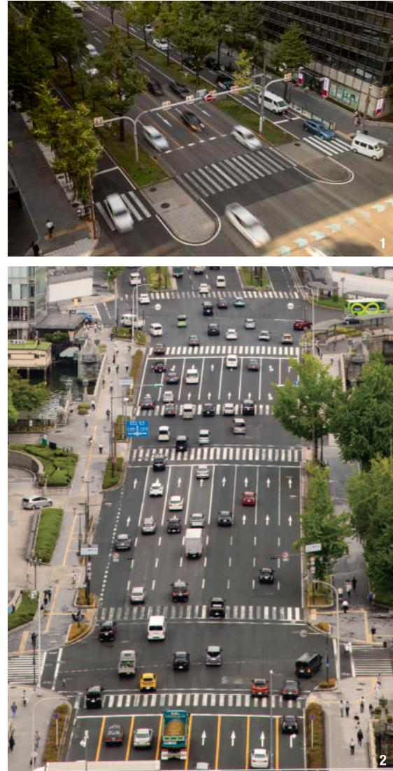
1.淀屋橋以南の御堂筋には、4車線道路の両側に緑地帯と側道が設けられている 2.梅田から淀屋橋までは側道と緑地帯がなく、6(最大8)車線の道路が続く
