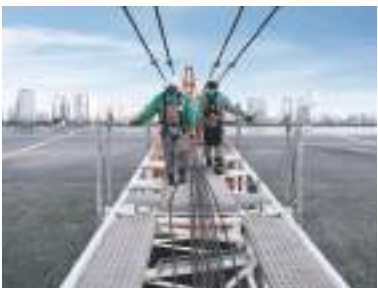
boom上面足場は、500mm×2列。中間boomの上面足場は、1,000mmに拡大
