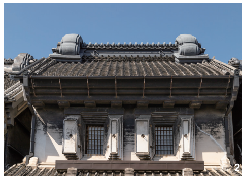
1.1913（大正2）年頃の新河岸川の船着場の様子。川越藩の経済を支えた新河岸川の舟運は、1931（昭和6）年まで現役だった（川越市立博物館図録より転載） 2.屋根の最上部には棟の腐食防止と装飾を兼ねた「箱棟」がのり、観音開きの窓は厚い耐火仕様。窓の下には「目塗台」が設けられるなど、川越の蔵造り建築の特徴がよく表れている
