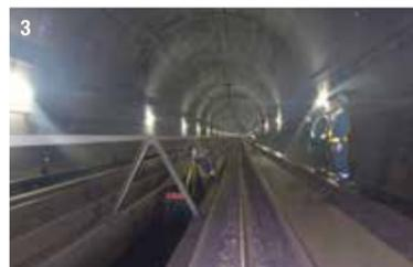
1. ケーブルカーの先は、実際に工作業で使われた地下坑道。現在その一部が「体験坑道」の見学コースになっている（写真提供：青函トンネル記念館／青森県外ヶ浜町）2. 坑道の一角にはトンネル工事で使われた道具や機械などを展示 3. トンネル内の変形状態を調べるために年に一度、内空変位の計測を行う。長大なため、すべてを計測するだけで1カ月以上を要する（写真提供：鉄道・運輸機構）
