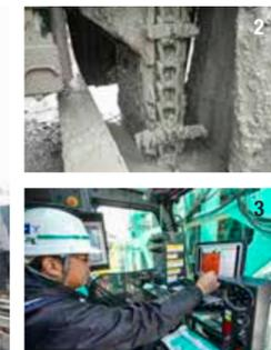
1.コベルコ建機が開発したTRD施工のためのメインマシン、TRD35-2。太洋基礎工業では計7台のTRD施工機を所有している 2. TRD施工機は、写真のチェーンソー型カッターポストを駆使し、横方向に移動させながら地盤を掘削。上下の刃を異なる長さにする事で、土壌を攪拌しやすくする工夫も施されている 3. TRD施工機のオペレータとして、日本屈指の技術を誇る増田隆宏さん。キャブ内に設置されたモニターで垂直性をリアルタイムで確認しつつ、高精度で施工していく
