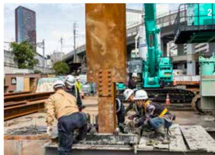
1. TRD工法の現場で稼働するTK750G。その役割は重さ3t、長さ15mにおよぶ芯材をつり上げ、TRD施工機が掘削した溝に次々と挿入することだ 2. 工事対象の道路は、直線ではなく微妙にカーブしていることから、芯材の挿入時に精度を欠きやすいという。そのため、人の目で常時確認しながら作業が進められていた
