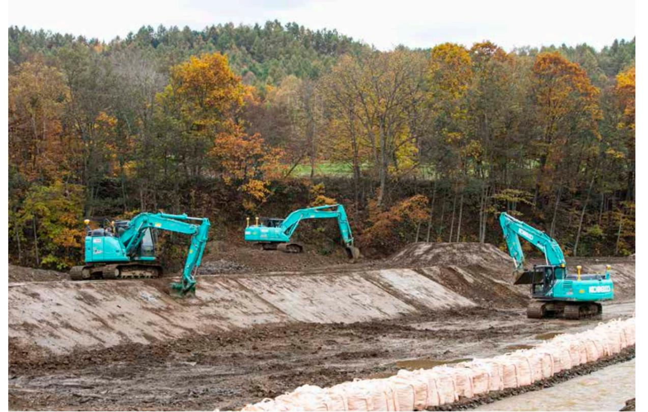
現場では複数台のコベルコ製ICT建機が活躍。SK135SR-5(左)は法面整形、SK200-10(中央・右)は掘削や土砂の積み込み作業に従事していた
