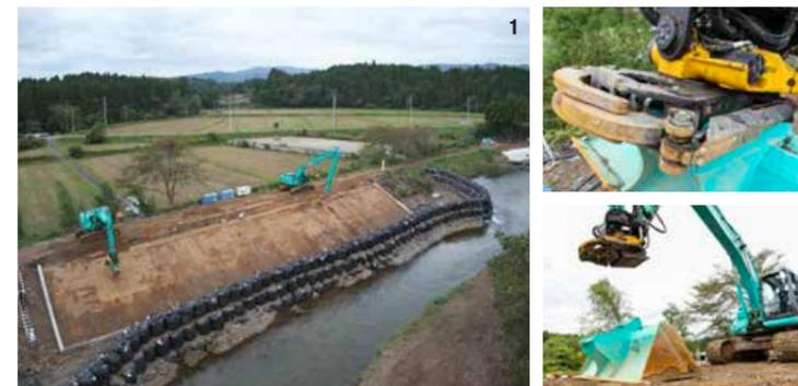
1. 現場では、チルトローテータ搭載のSK200-9が法面を整形。もう1台のコベルコ機が土砂などの積み込みといった役割を担っていた 2. チルトローテータには、物をつかむことができる簡易荷役用クラブも付属。「ワイヤによる玉掛けが不要で、ちょっとした物を運ぶのはとても便利です。この現場でも、河川の小枝や倒木を運ぶ際に役立ちました」(相田さん) 3. 法面整形や掘削など、作業に合わせたバケットへの交換もワンタッチで行える
