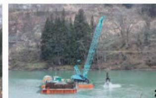
1.ダム湖に堆積した総量30,000㎡もの土砂を、組立式台船に運び込んだクローラークレーンによって1日500㎡ずつ取り除いていく 2.土砂をつかむとバケットが重くなるうえ、台船の上での揺れが加わるため、荷振れや接触を起こさないよう細心の注意が必要
