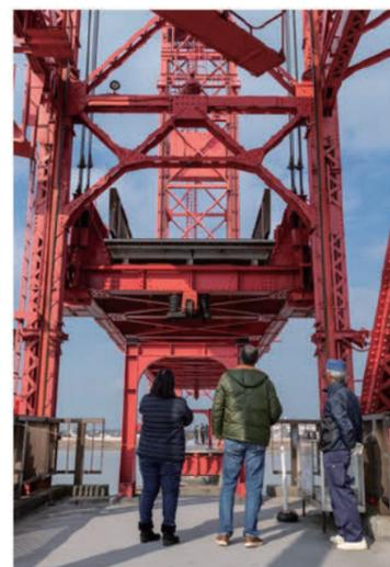
船舶の通行が優先されていたため、列車が通る時以外は、可動部は23mの高さまで上げられていた。時間通りに昇降するため、時計代わりになっている人もいたという
