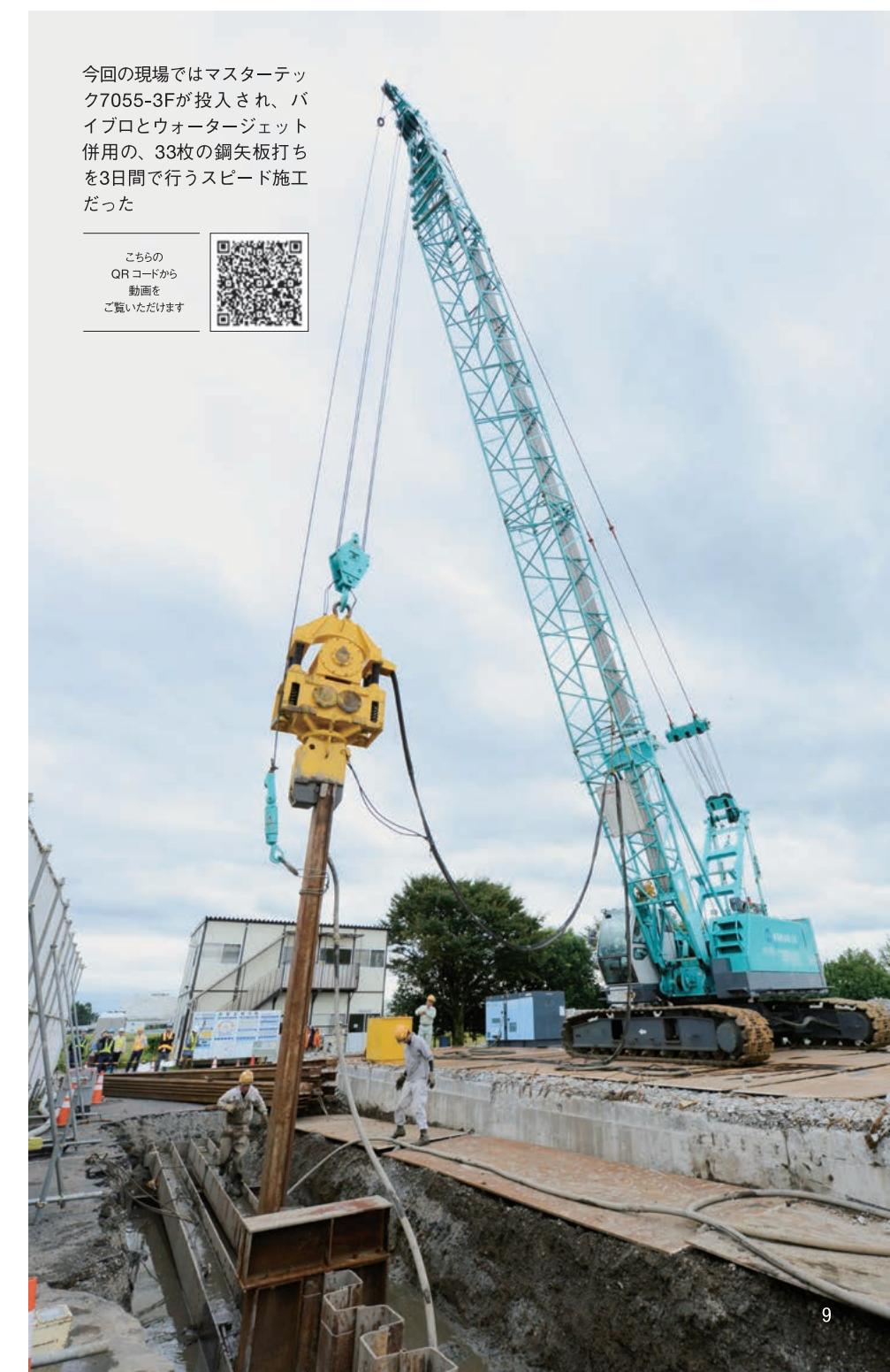
今回の現場ではマスターTEKK7055-3Fが投入され、パイプロとウォータージェット併用の、33枚の鋼矢板打ちを3日間で行うスピード施工だった
