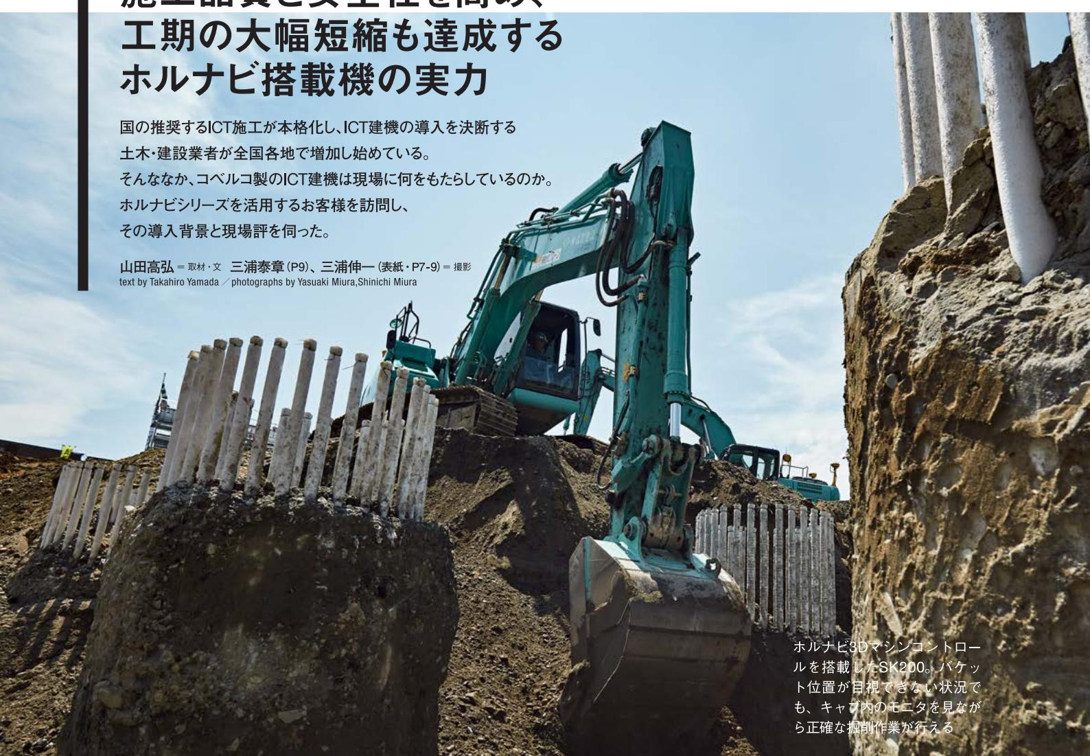
ホルナビ3Dマシンコントローラを搭載したSK200。バケット位置が目視できない状況でも、キャブ内のモニタを見ながら正確な掘削作業が行える
