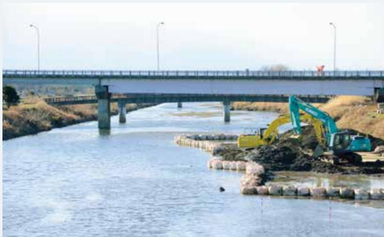
河床から2000m<sup>3</sup>の土砂を掘削して整形する本工事は、従来なら2カ月の工期がかかるが、ホルナビ+PLUS搭載機の導入で2～3週間の工期短縮ができる予定だ。
