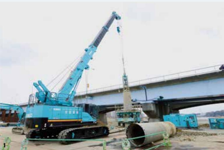
1.関戸橋の基礎工事現場は既存の橋のすぐ近く。安全には特に気を使つて作業を進めている 2.下流側の橋の撤去前に、上流側の橋に沿つて建設中の仮橋。橋脚には鋼管を使用
