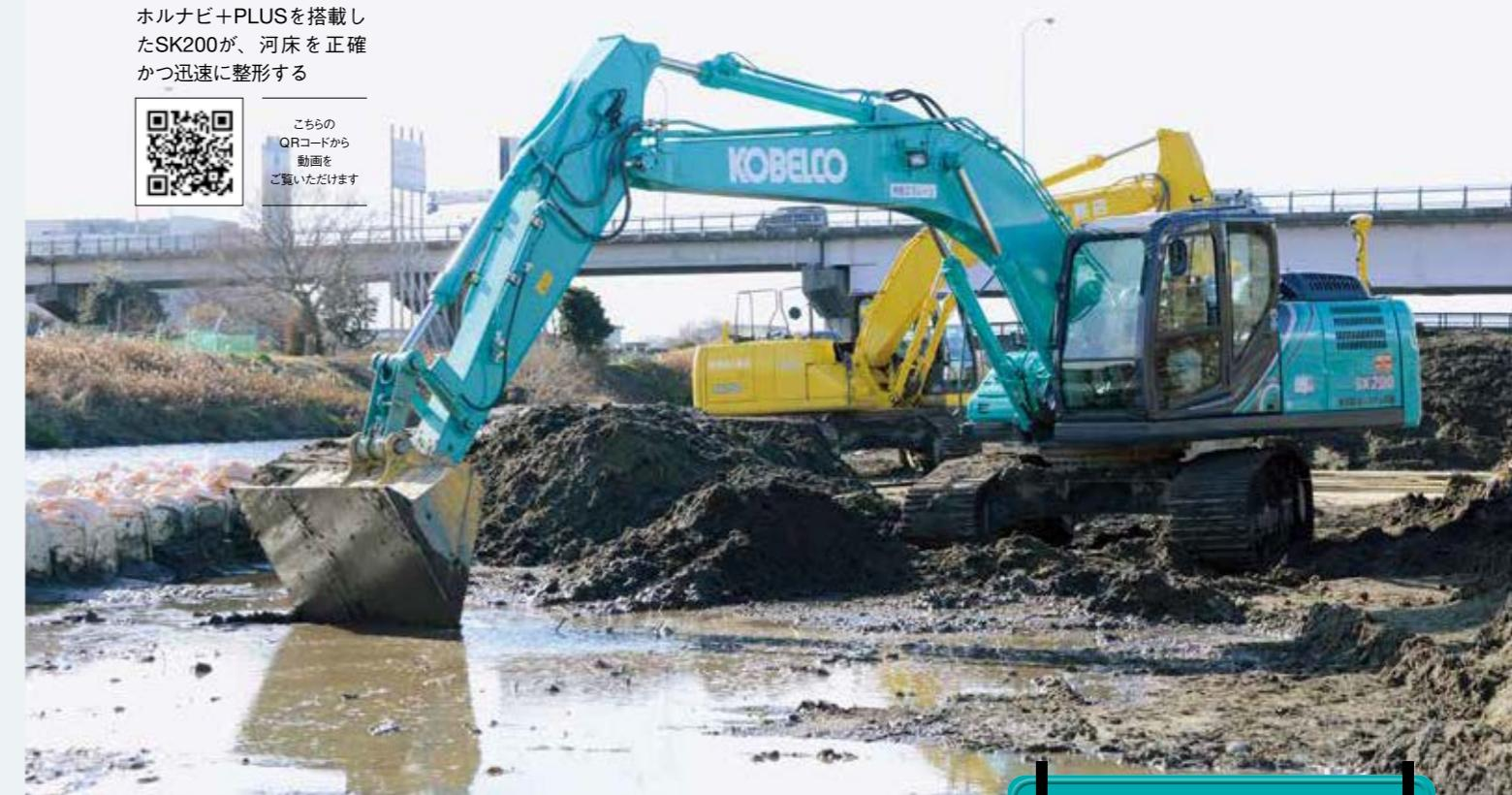
ホルナビ+PLUSを搭載したSK200が、河床を正確かつ迅速に整形する
