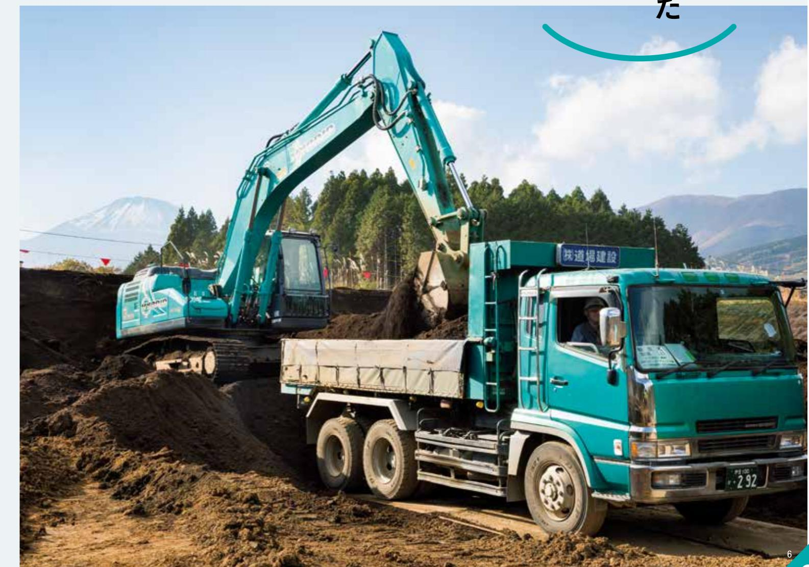
1 新東名高速道路本線の中央分離帯となる部分。この工区では2016～2020年の工期で約32万m<sup>3</sup>の土砂を掘削するため、SK200H-10はフル稼働。ハイブリッドならではの燃費効率が効果を発揮している。2 法面整形の作業は繊細さを要する。オペレータの技術とショベルの操作性が問われる場面だ
