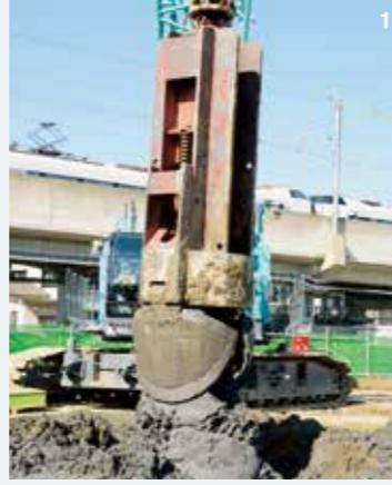
1.ハンマークラップをケーシングチューブの内部に投入し、掘削・排土を行うことでコンクリートを流し込む孔を造る 2.BM1000Gのオペレータ、河野英二さん。「尿素水でNOx排出量を低減し、排気時の煙を抑制できるエンジンを搭載しているので、現場周辺への配慮ができ、助かっています」3.北陸新幹線の延伸工事現場では、長さ42.5m、直径1500mmの杭を約700本打つ予定。河野組は、そのうちの約100本を担当
