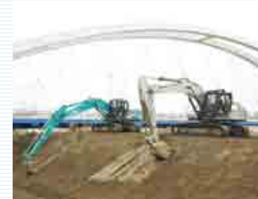
ハイブリッドショベル(SK200H)稼働現場
