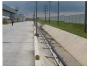
③大雨などによる工場排水の外部流出を防ぐ溝
