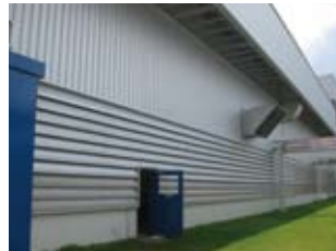
①自然換気するためのスリット構造の壁
